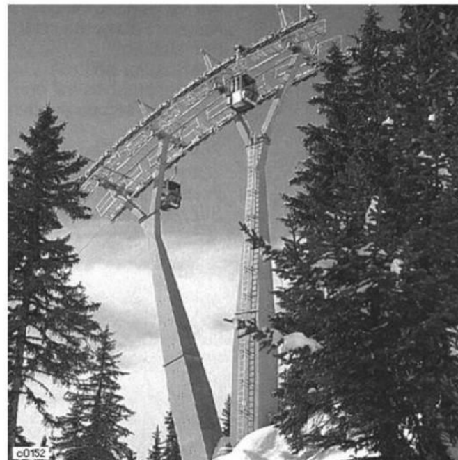
Dvojni škatlasti steber v Y izvedbi
