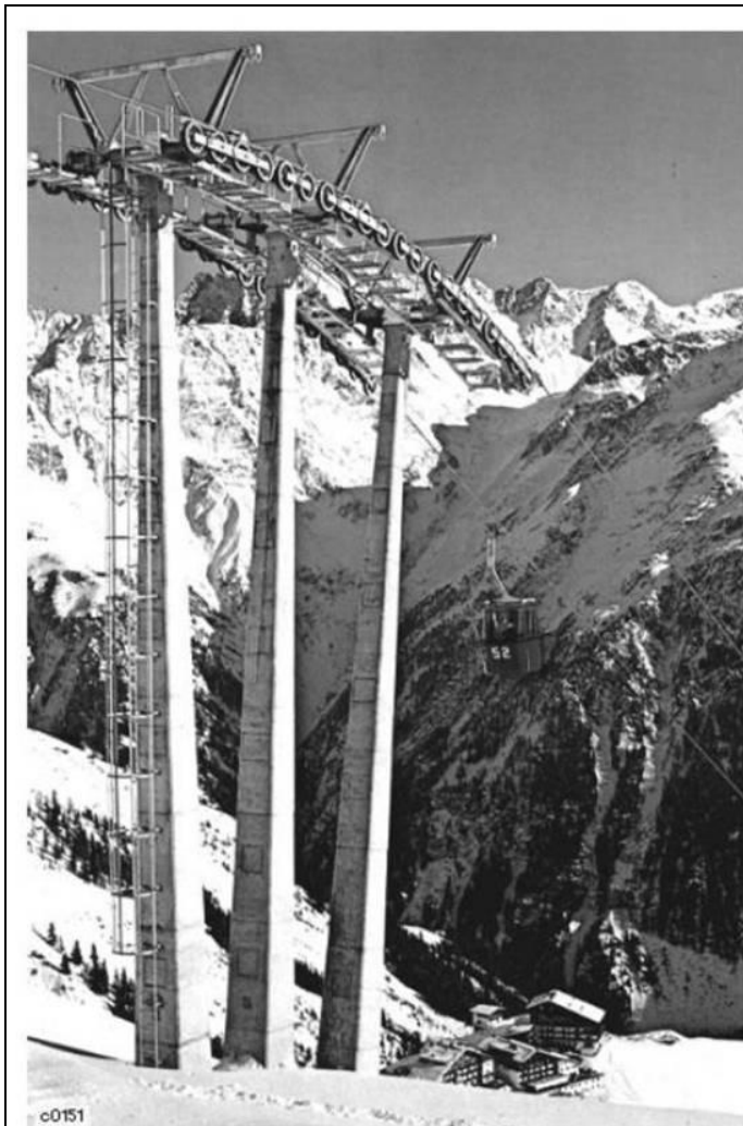
Trojni betonski steber
